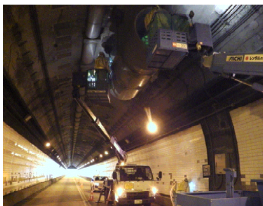
▲換気設備（ジェットファン）点検イメージ
