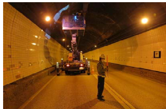
▲トンネル本体点検イメージ
