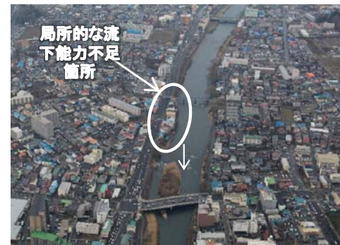
四十四田ダム下流の流下能力不足箇所
