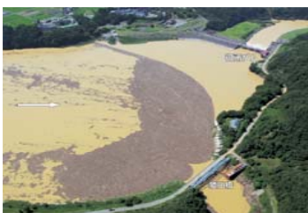
御所ダム洪水調節状況（H25.8洪水） 洪水調節容量をほぼ満杯まで使い、ダム下流盛岡市街地などの被害を防いだ。
