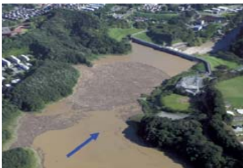
四十四田ダム洪水調節状況（H25.9洪水） 洪水調節と併せて大量の流木を捕捉し、ダム下流盛岡市街地などの被害を防いだ。
