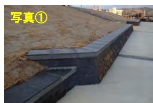
石積護岸整備状況
