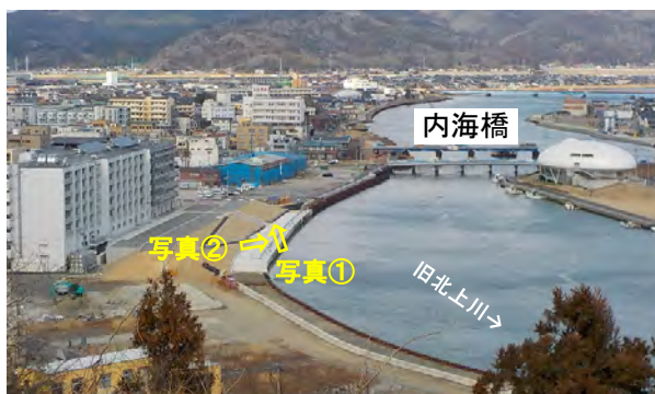
中央地区堤防整備状況
