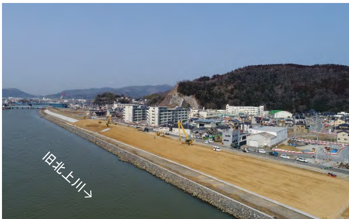
① 左岸湊地区の堤防復旧状況
