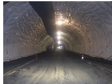
防水シート貼付
