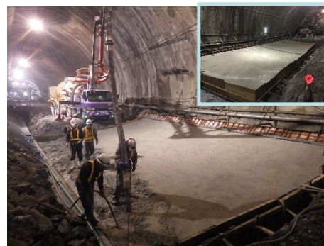
インバートコンクリート打設
