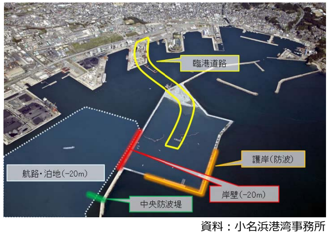
▼小名浜港 東港地区整備の状況
