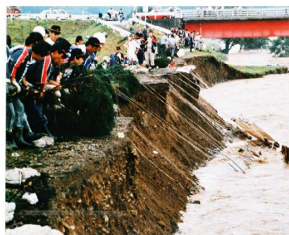
昭和62年8月洪水 成瀬川左岸における水防活動
