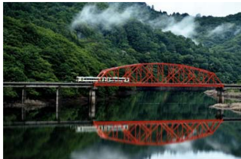
＜「第二和賀川橋梁」を走るJR北上線＞
