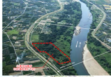
天童市蔵増地先(右岸:村山橋上流)
