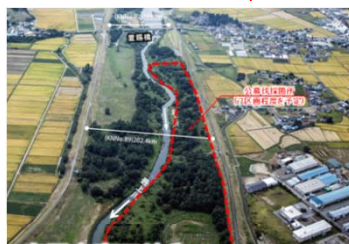
米沢市窪田地先 (左岸:置賜橋下流)
