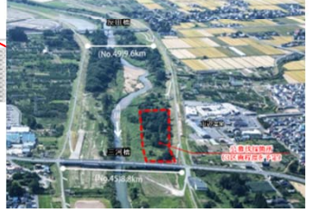
山辺町大塚地先(須川左岸:三河橋上流)
