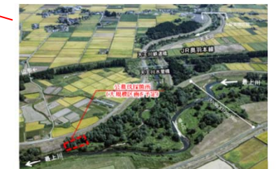
高島町露藤地先(右岸:天王川下流)
