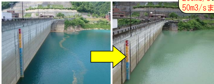
防災操作開始前の貯水位 EL. 385.9m
