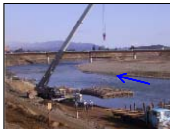
吊り込み状況
