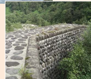
玉石張りした堰堤→
