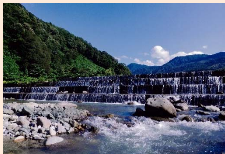
瀬場砂防堰堤正面
