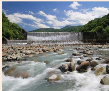
六瀨砂防堰堤正面
