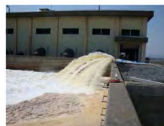
東日本大震災での排水ポンプ排水状況 (福島県沿岸地域)
