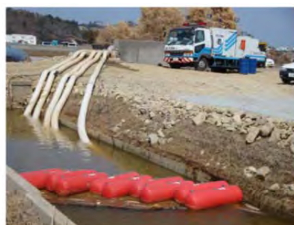
東日本大震災での排水ポンプ設置状況 (福島県沿岸地域)
