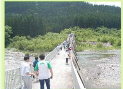
生保内川遊砂地
