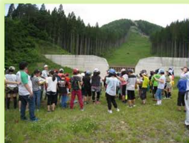
供養佛沢砂防堰堤
