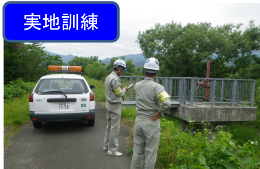
点検及び被災状況の報告
