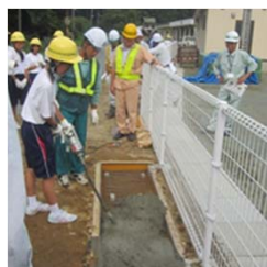
コンクリート打設体験
