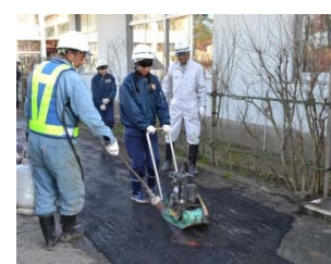
舗装修繕体験
