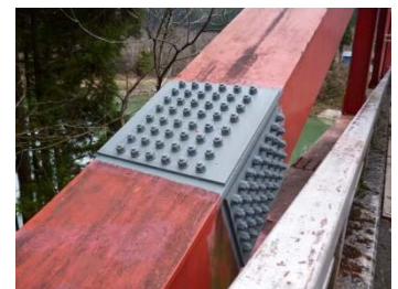
▲ボルト交換・下塗完了後
