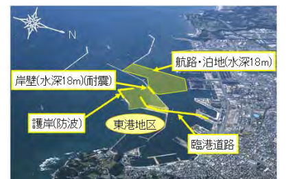
▼小名浜港 東港地区整備の状況
