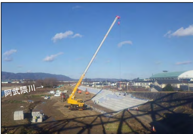
▲工事の進捗状況
