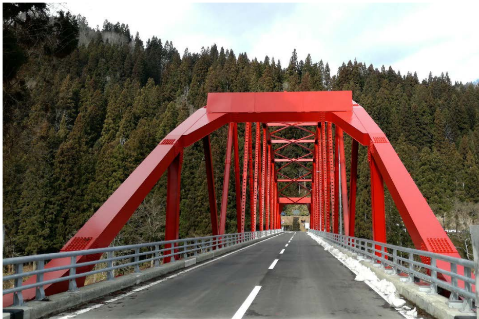
▲三島大橋 全景
