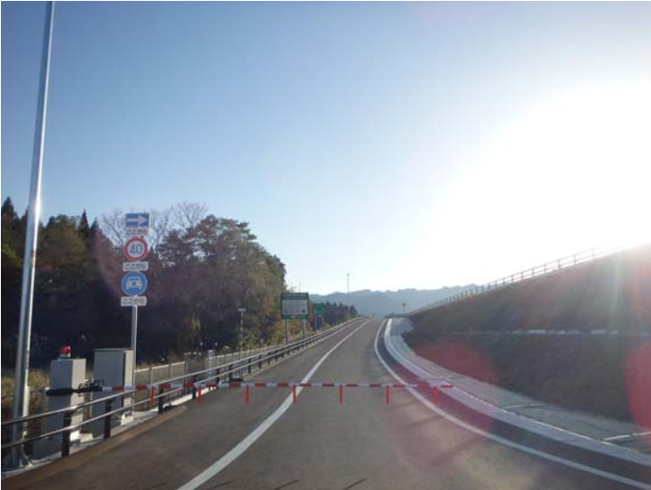
日本海東北自動車道 二井田真中ICの設置状況
