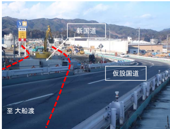
写真①(切替起点部)
