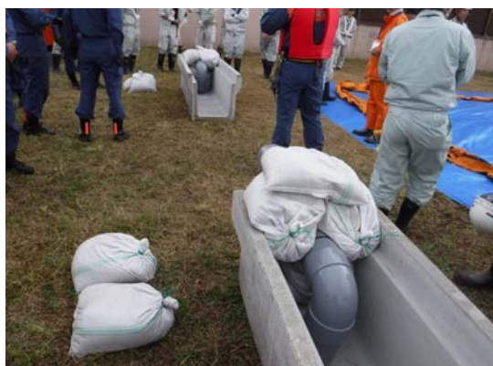
側溝での油流出防止対策訓練
