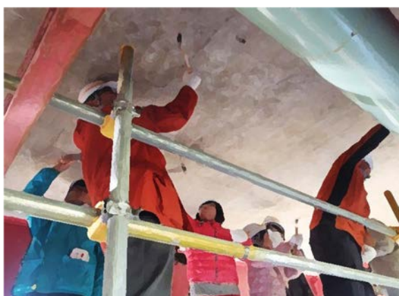
近接目視点検
