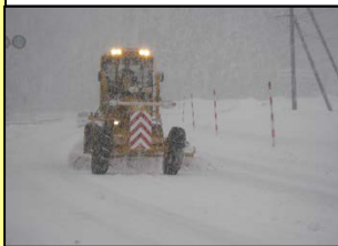
除雪グレーダによる作業状況
