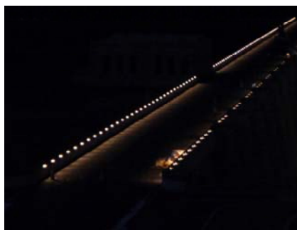
【ダムの高欄に設置した照明も点灯】 （撮影日：平成28年10月11日）
