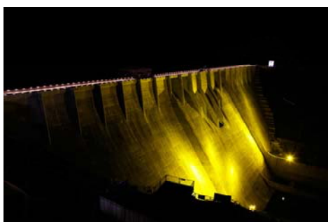
【試験的にライトアップした津軽ダム】 （撮影日：平成28年10月11日）
