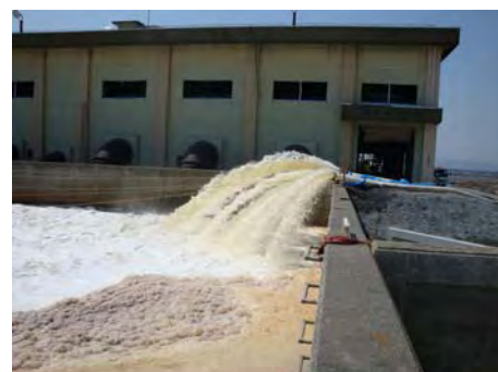
東日本大震災での排水ポンプ排水状況 （福島県沿岸地域）
