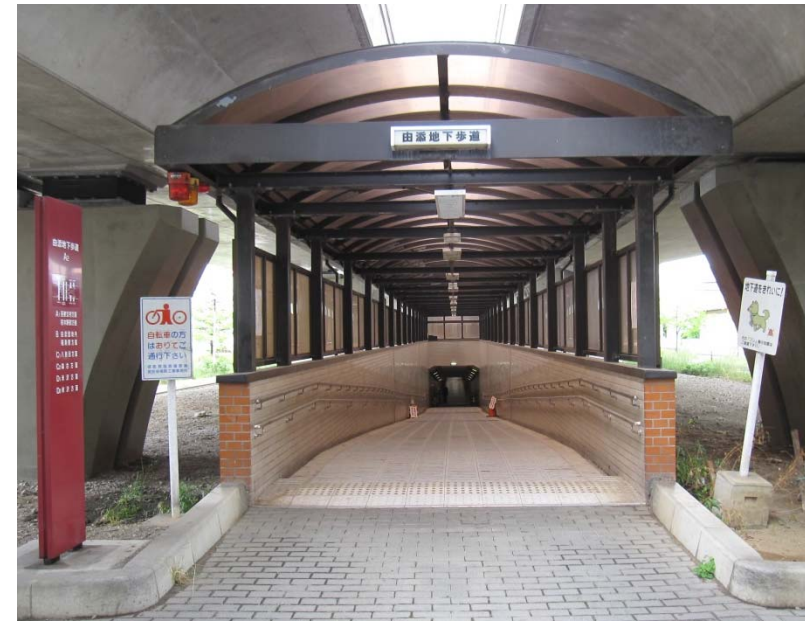
由添地下歩道の様子
