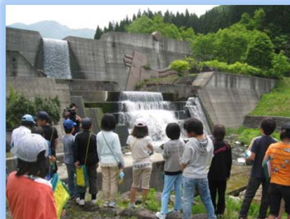
小先達川第1砂防堰堤
