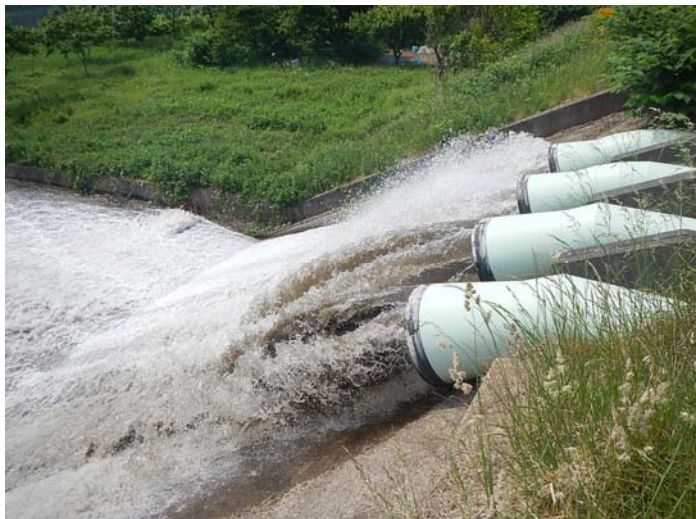
昨年度の内水排除訓練の状況(大曲排水機場)
