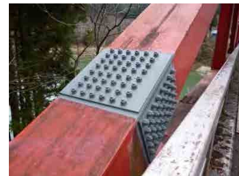
▲ボルト交換・下塗完了後
