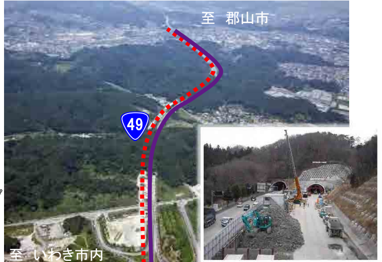
▲平バイパス4車線化施工状況
