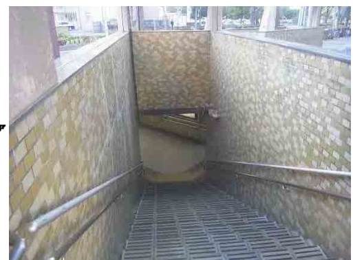
▲急勾配(勾配50%)な階段
