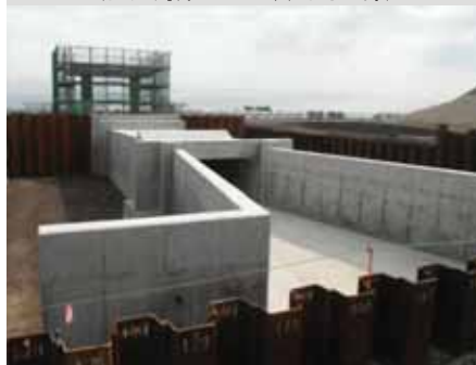
仙台湾南部海岸の堤防復旧状況 (山元海岸 一の沢川河口部)
