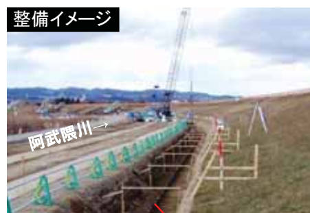
浸透対策(遮水矢板工)
