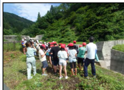
④施設学習【二の沢砂防堰堤】
