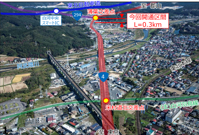
①白河拡幅の写真 (米村道北交差点上空から北東方面を望む)
