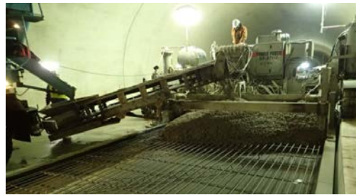
特殊機械によるコンクリート打設・敷均し
