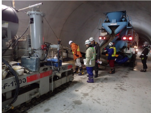
特殊機械によるコンクリート打設・敷均し
