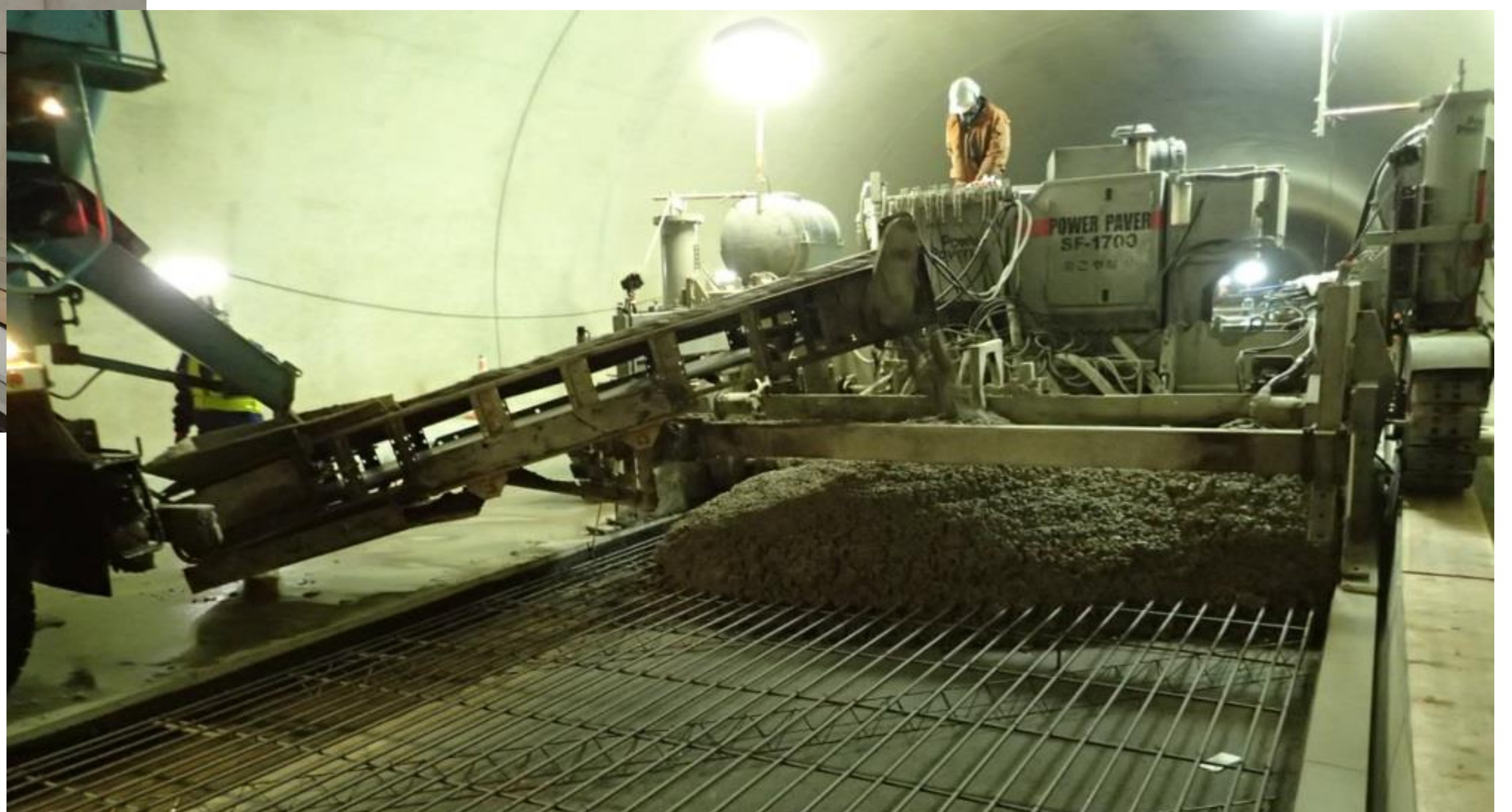
平成26年度の施工中の様子
