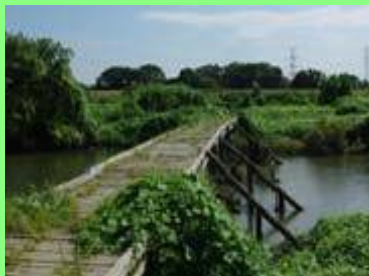
ピオトープの整備
