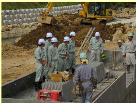
現場体験:実際に施工現場を見学
