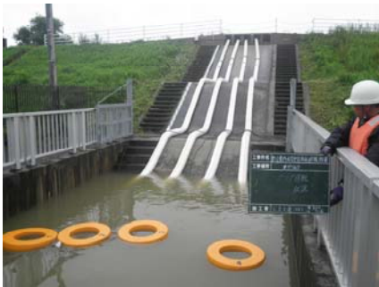
排水ポンプ設置状況
