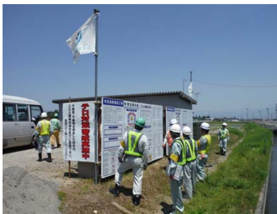
▲安全パトロールの様子
