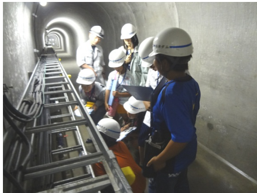
（監査廊内で点検計測）
