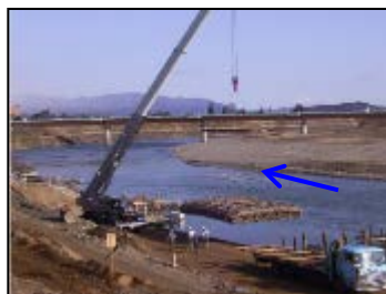
吊り込み状況
