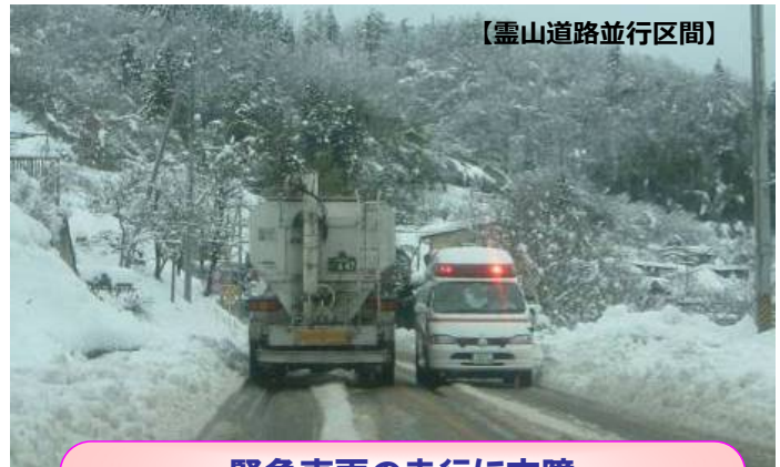
緊急車両の走行に支障
