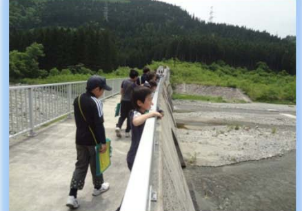
生保内川遊砂地
