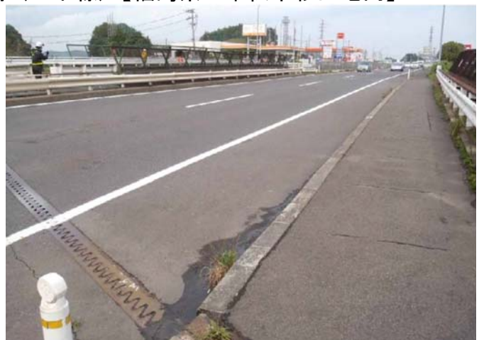
▲北杉田跨線橋 (上り線)
