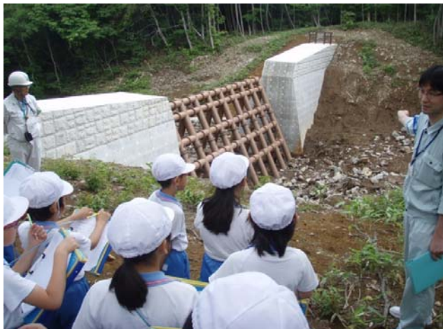
「小水無沢第1砂防堰堤」で、実際の堰堤を見てその大きさを確認
