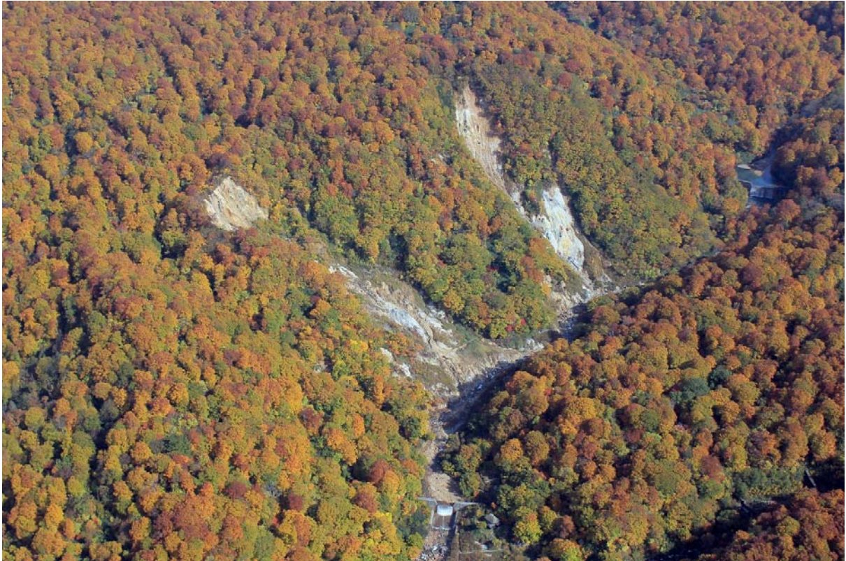
平成9年5月 先達川上流土砂崩落箇所【2011.10撮影】
