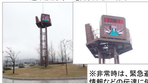
<通常放流時の電光表示板の様子>
