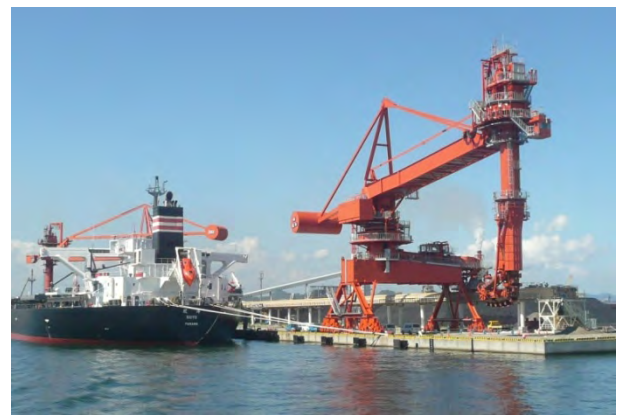
▲石炭運搬船による荷役状況
