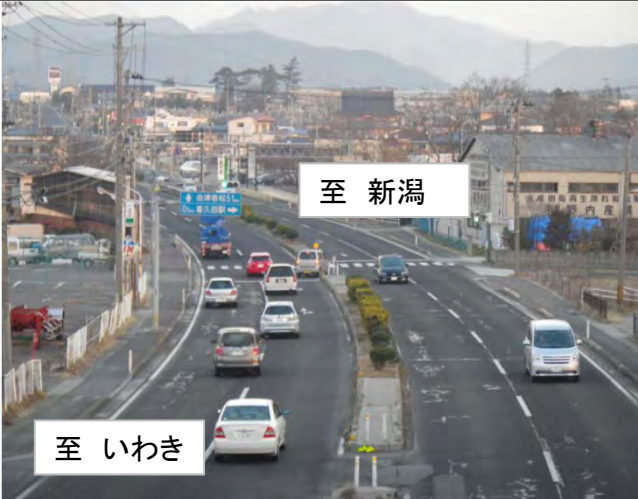
▲右折車が直進車を阻害している状況
