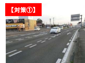
▲減速路面標示の設置(直進車線)
