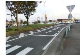
▲減速路面標示の設置(左折車線)・セブラ設置
