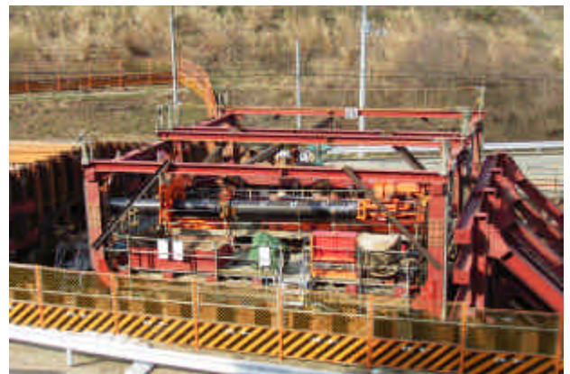
写真 - 2 発進架台詳細写真
